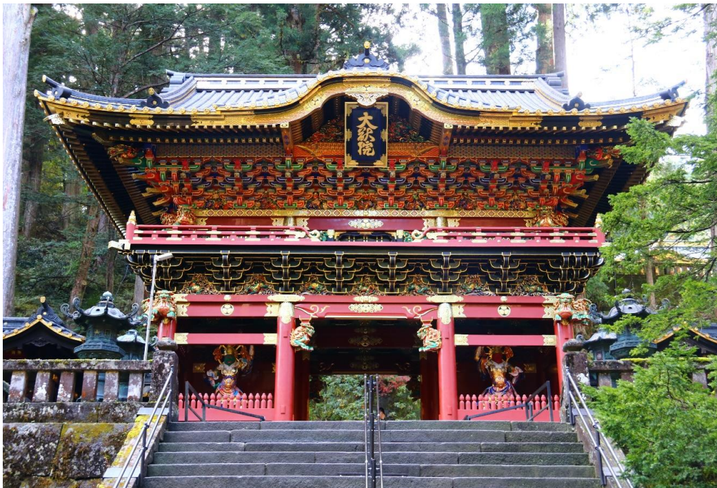
日光山輪王寺 大猷院(二天門) (11月5日撮影) 平成24年より改修をして来た二天門が六年という歳月を経て、その美しさが現世に蘇りました。
